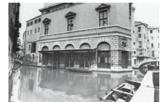
Westfassade am Rio de le Veste
