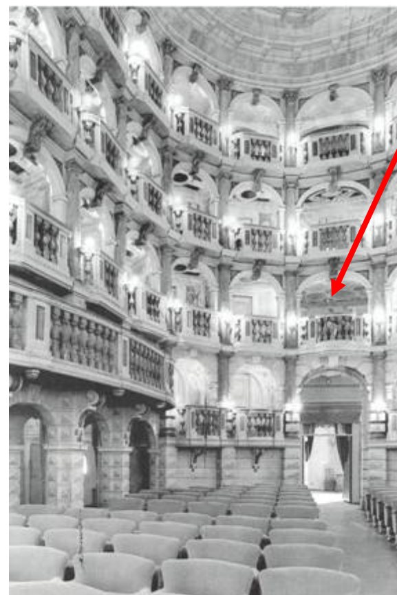
Blick auf den Wandaufbau und das Hauptportal
