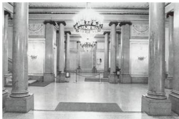
querliegende Eingangshalle mit ionischen Säulen
